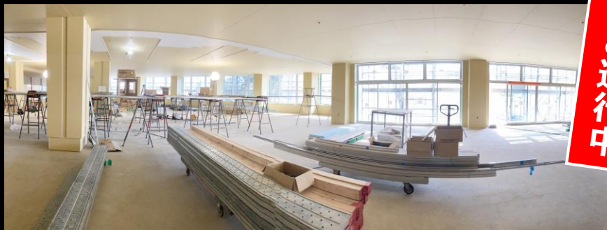
▲天井高2.9mの解放感のある食堂（1階）
